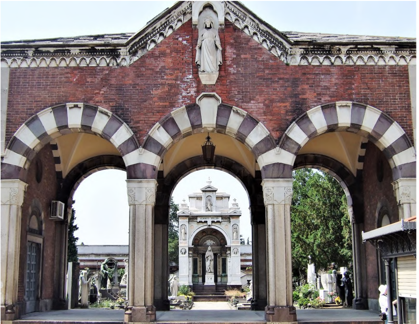
Il Cimitero Monumentale di Milano - Ingresso Acattolici - ingang tot het niet-katholieke deel van de begraafplaats met zicht op het graf van Alberto Keller -
