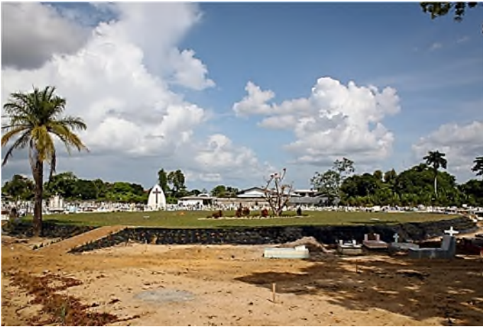
de aanleg van een terp
